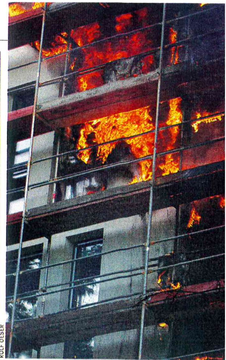
Fassadenbrand eines Apartmenthauses Ende
